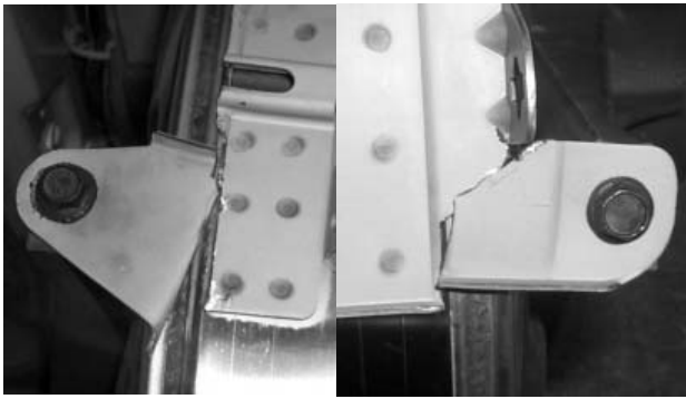
Figure 2: Broken outer holder without fatigue-crack propagation Slika 2: Zlomljeni zunanji nosilci brez vidne utrujenostne rasti razpoke
