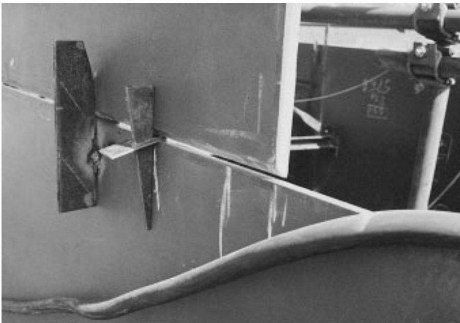
Slika 7: Spenjanje pločevin za horizontalno varjenje v steni Figure 7: Plates binding for horizontal welding position (2G)
