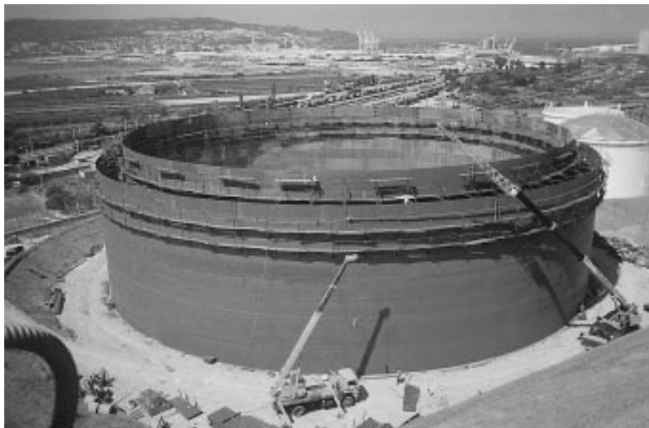
Slika 8: Končano varjenje jeklenega lovilnega bazena ter končana montaža desetega venca rezervoarja Figure 8: The end of reservoir welding and completion of tenth tank wreath
