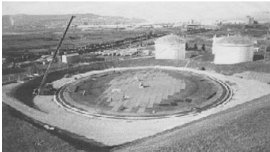
Slika 3: Montaža podnice rezervoarja Figure 3: Assemble of tank bottom
