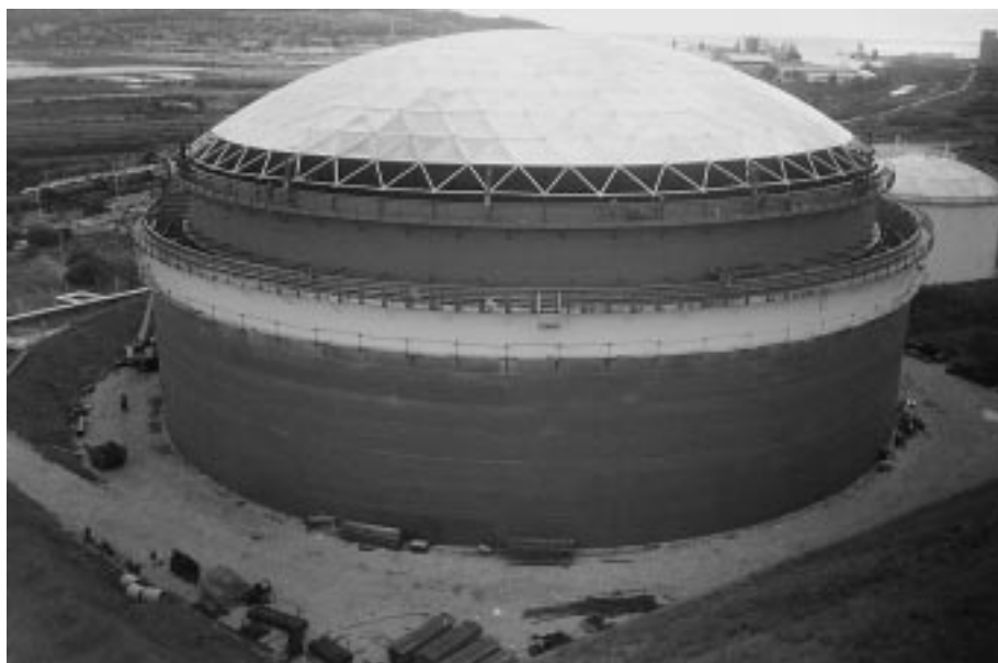
Slika 9: Montaža kupolaste strehe iz aluminijske zlitine po končanju varilskih del na plašču rezervoarja in plašču jeklenega lovilnega bazena Figure 9: Assemble of aluminum dome roof after welding on tank shell and reservoir
