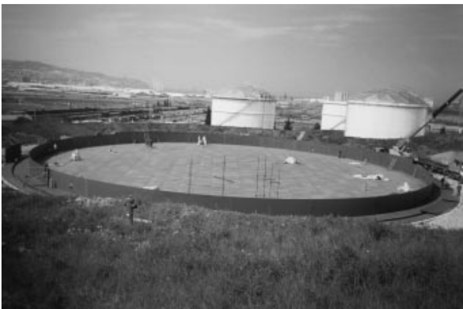
Slika 4: Varjenje vertikalnih zvarov na prvem vencu rezervoarja in montaža prvega venca lovilnega bazena Figure 4: Welding of vertical welding joints on first tank wreath and assembling of first reservoir wreath
